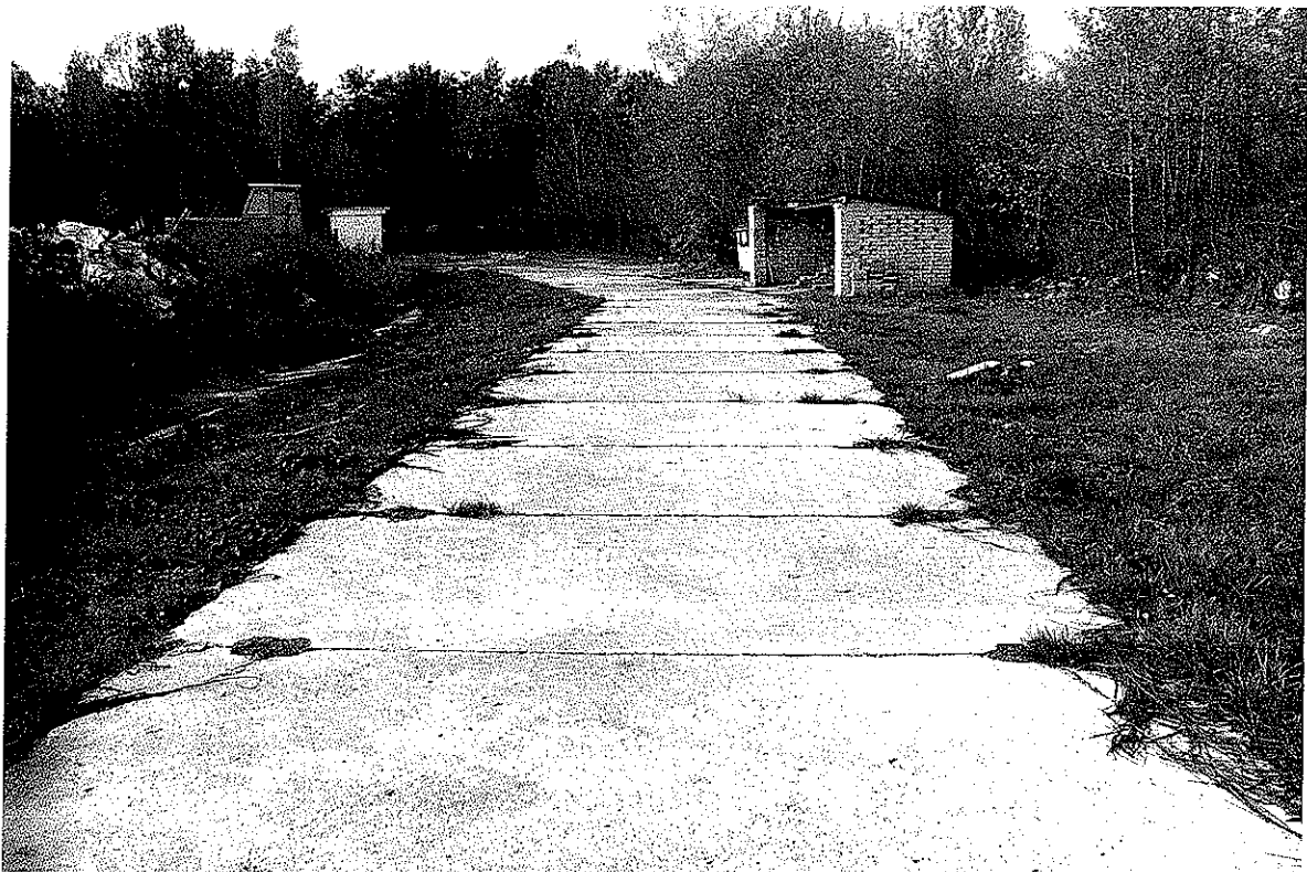
Fot. nr 6. Widok na fragment drogi technologicznej wzdłuż północno - zachodniej granicy kwatery składowiska. Droga i widoczna na drugim planie wiata ceglana przeznaczone do likwidacji.
