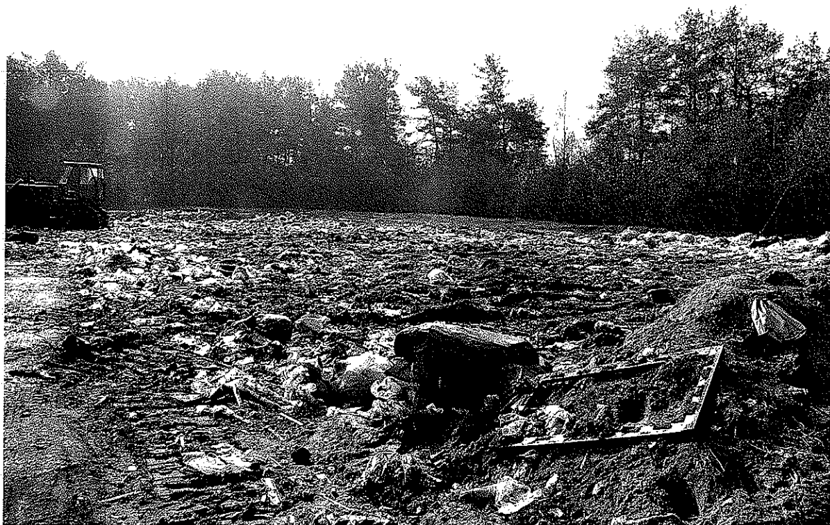
Fot. nr 1. Widok na południowy fragment składowiska. Widoczna spycharka gąsienicowa służąca do przemieszczania i przyzmuwania odpadów oraz pełniąca rolę kompaktora
